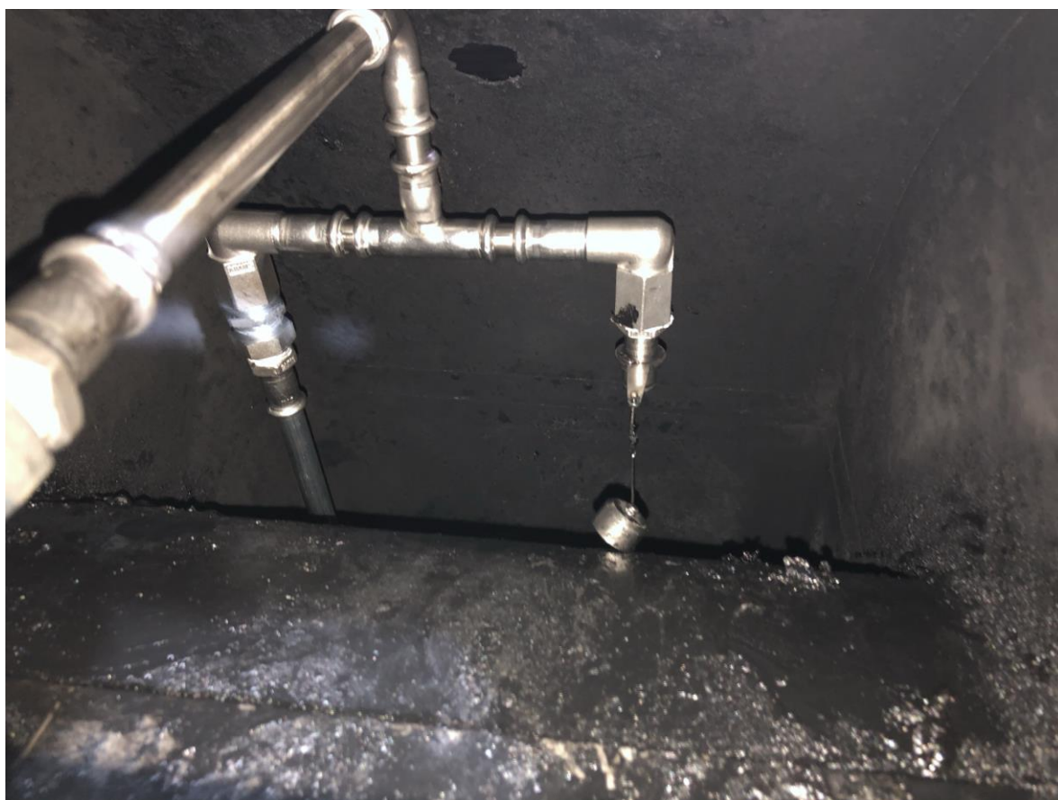
Fig. 4: boquillas extinción en conducto
