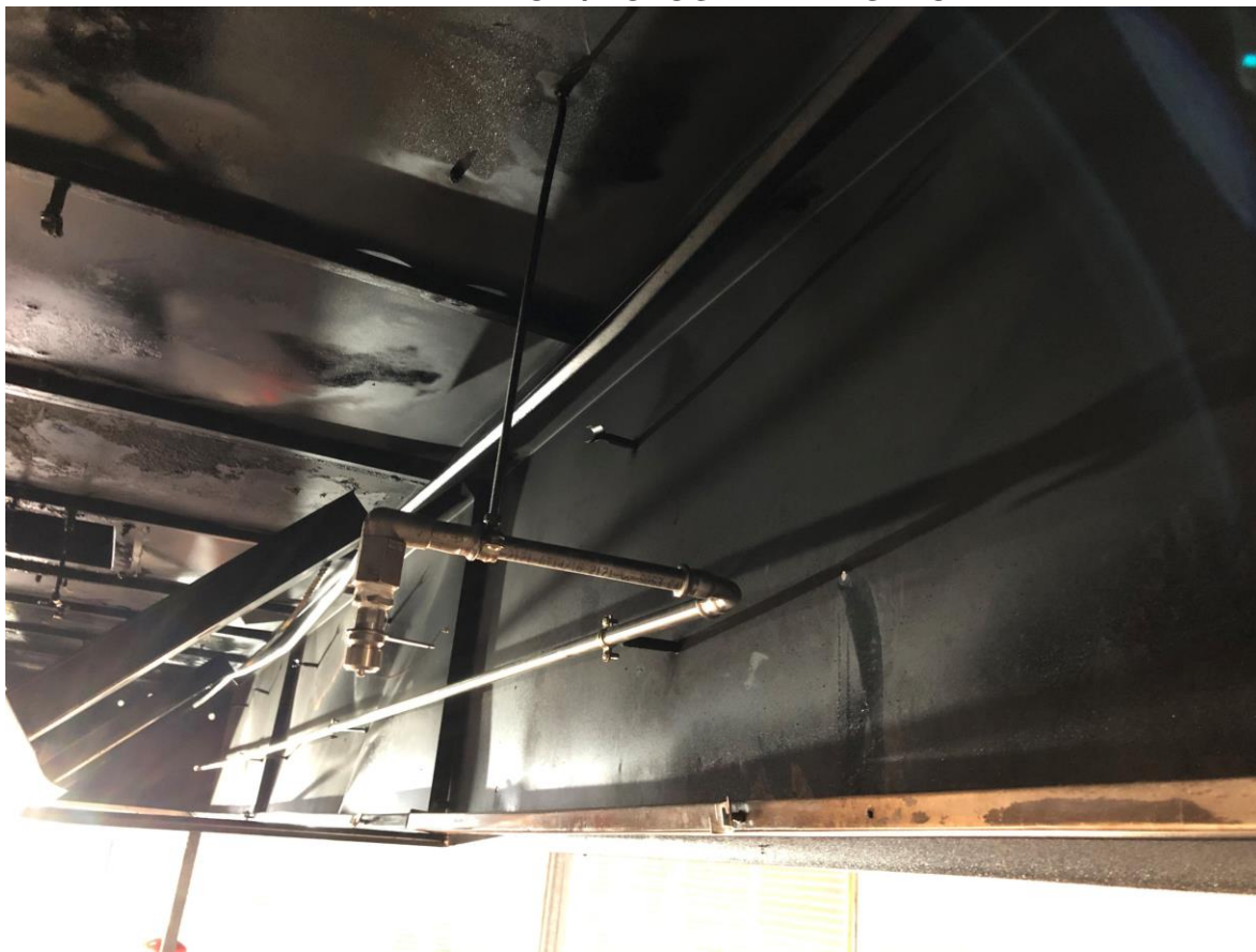
Fig. 1: Boquilla descarga freidoras
